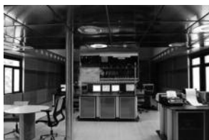
SCADA. Sala de comandament i control de FEDA.
